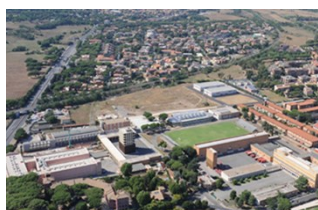
Scuole Centrali Antincendi
